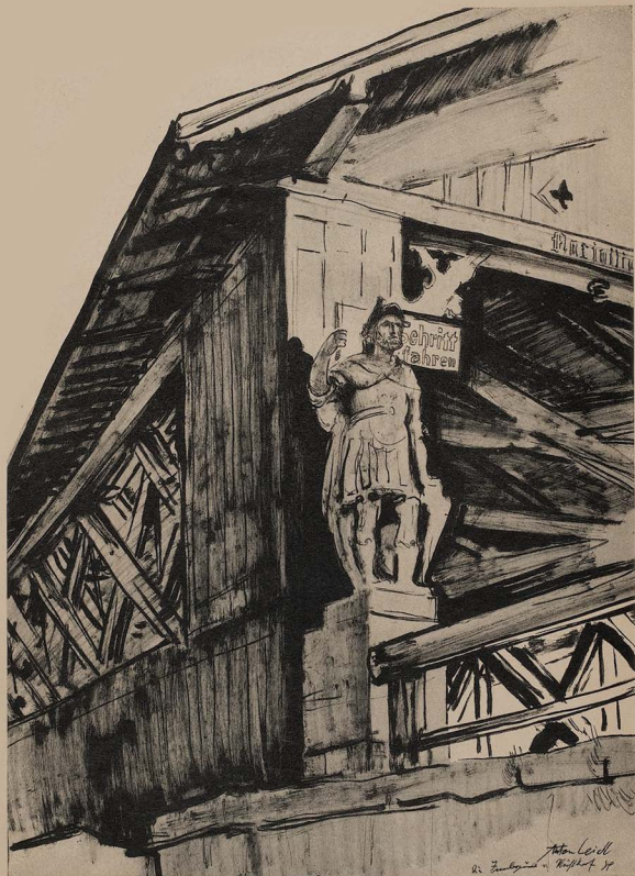
Die Innbrücke bei Mühldorf
